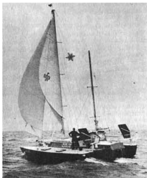
«Виктресс» был тримараном массового промышленного производства, способным выжимать до 22 узлов. Однако судно такого типа неспособно вставать на ровный киль после опрокидывания, и плавание по Южному океану должно было стать для него «моментом истины».
